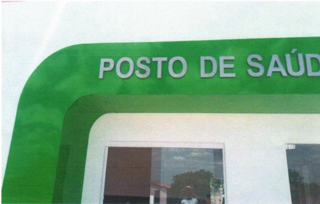
Foto 09- Letra em alumínio 20 x 20cm – instalado
