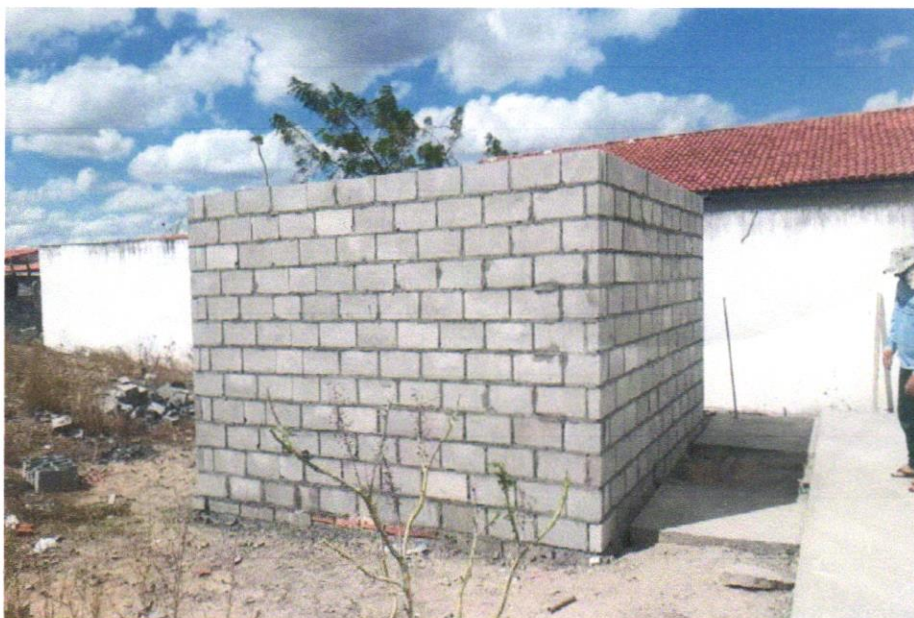
Foto 04 - ALVENARIA DE BLOCOS DE CONCRETO ESTRUTURAL 14X19X29 CM, (ESPESSURA 14 CM) FBK = 14,0 MPA, PARA PAREDES COM ÁREA LÍQUIDA MAIOR OU IGUAL A 6M 2 , SEM VÃOS, UTILIZANDO PALHETA. AF_12/2014
