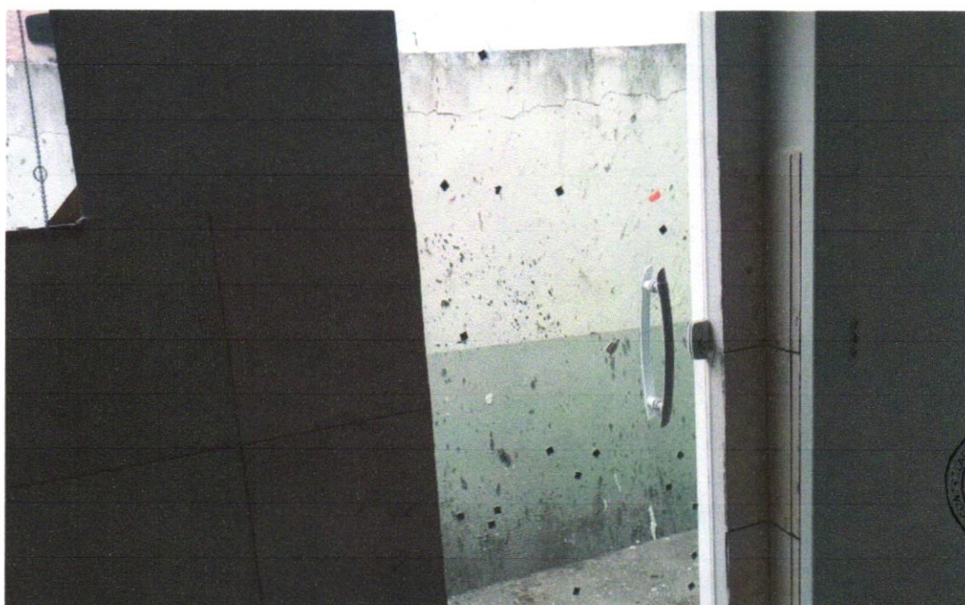
Foto 12 - Porta em vidro temperado 10mm, incolor, inclusive ferragens de fixação e instalação, exclusive puxador - Rev 01_10/2021
