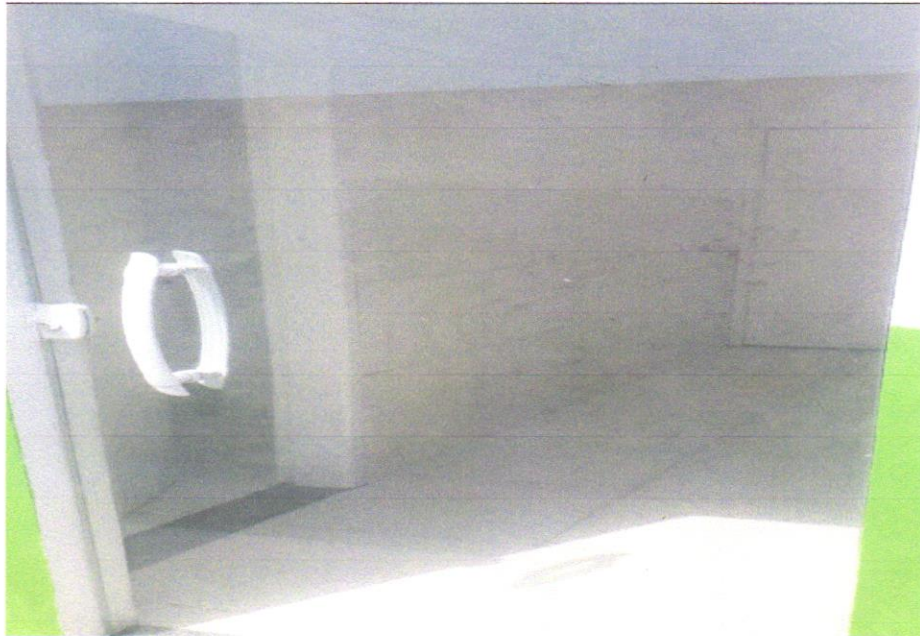
FOTO 23 – Porta em vidro temperado 10mm, incolor, inclusive ferragens de fixação e instalação, exclusive puxador - Rev 01 _10/2021
