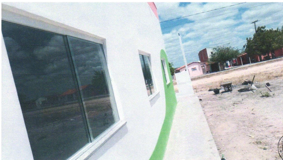
Foto 16 - APLICAÇÃO MANUAL DE PINTURA COM TINTA LÁTEX ACRÍLICA EM PAREDES, DUAS DEMÃOS. AF_06/2014
