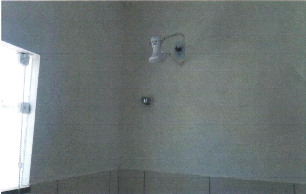
Foto 07- CHUVEIRO ELÉTRICO COMUM CORPO PLÁSTICO, TIPO DUCHA □ FORNECIMENTO E INSTALAÇÃO. AF_01/2020
