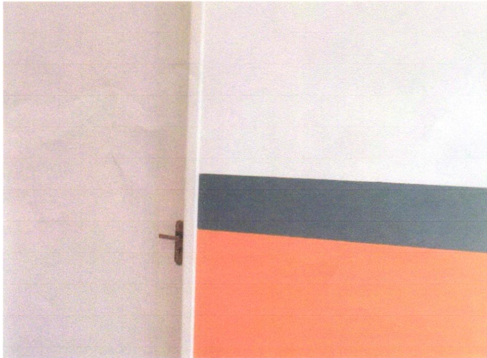
Foto 13 - FECHADURA DE EMBUTIR PARA PORTA DE BANHEIRO, COMPLETA, ACABAMENTO PADRÃO MÉDIO, INCLUSO EXECUÇÃO DE FURO - FORNECIMENTO E INSTALAÇÃO. AF_12/2019
