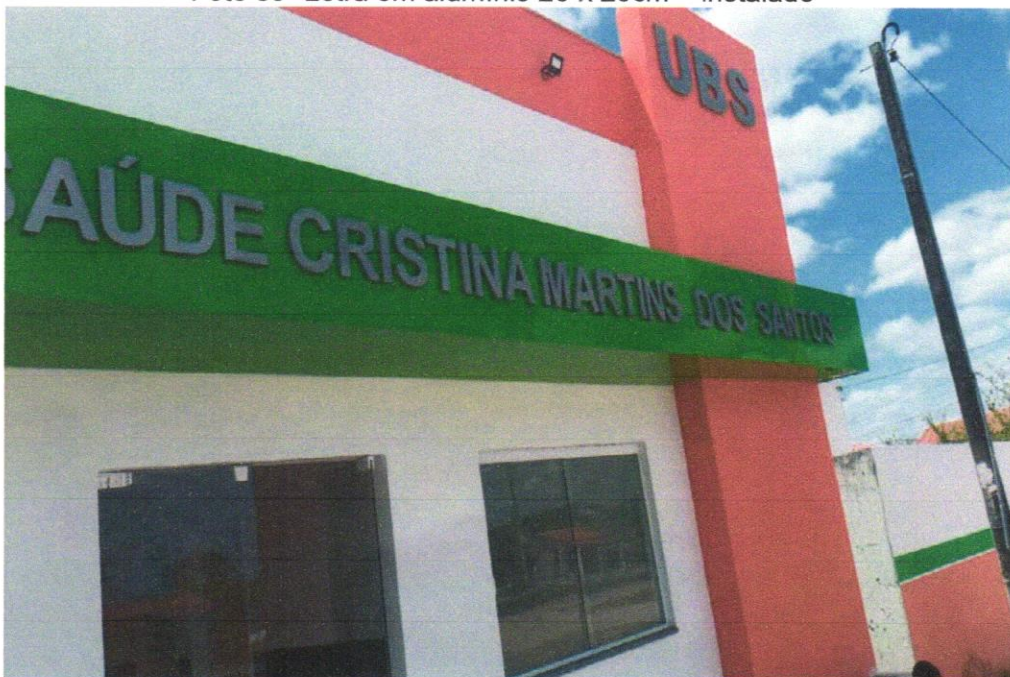
Foto 10 - Letra em alumínio 45 x 45cm – instalado
