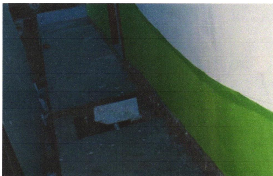
FOTO 28 – Caixa de inspeção 0,30 x 0,30 x 0,40m
