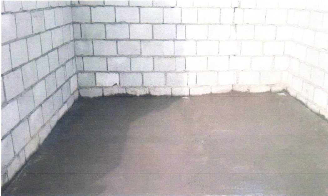
Foto 05 - Concreto simples fabricado na obra, fck=25 mpa, lançado e adensado
