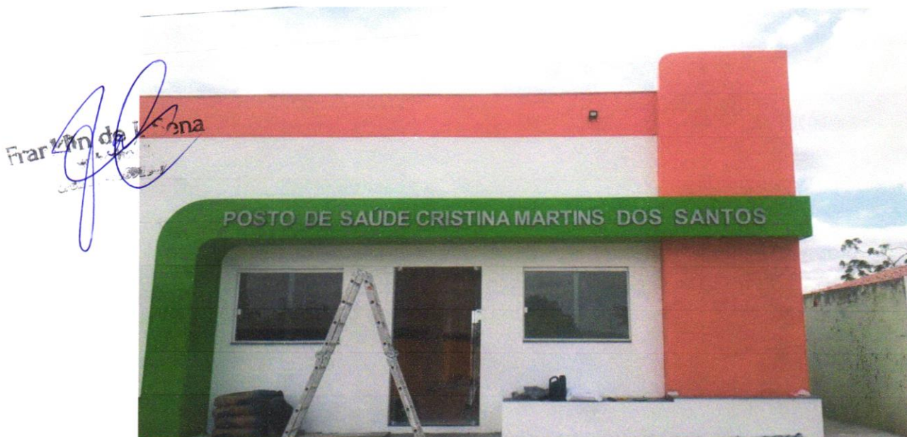
FOTO 20 – APLICAÇÃO MANUAL DE PINTURA COM TINTA LÁTEX ACRÍLICA EM PAREDES, DUAS DEMÃOS. AF_06/2014
