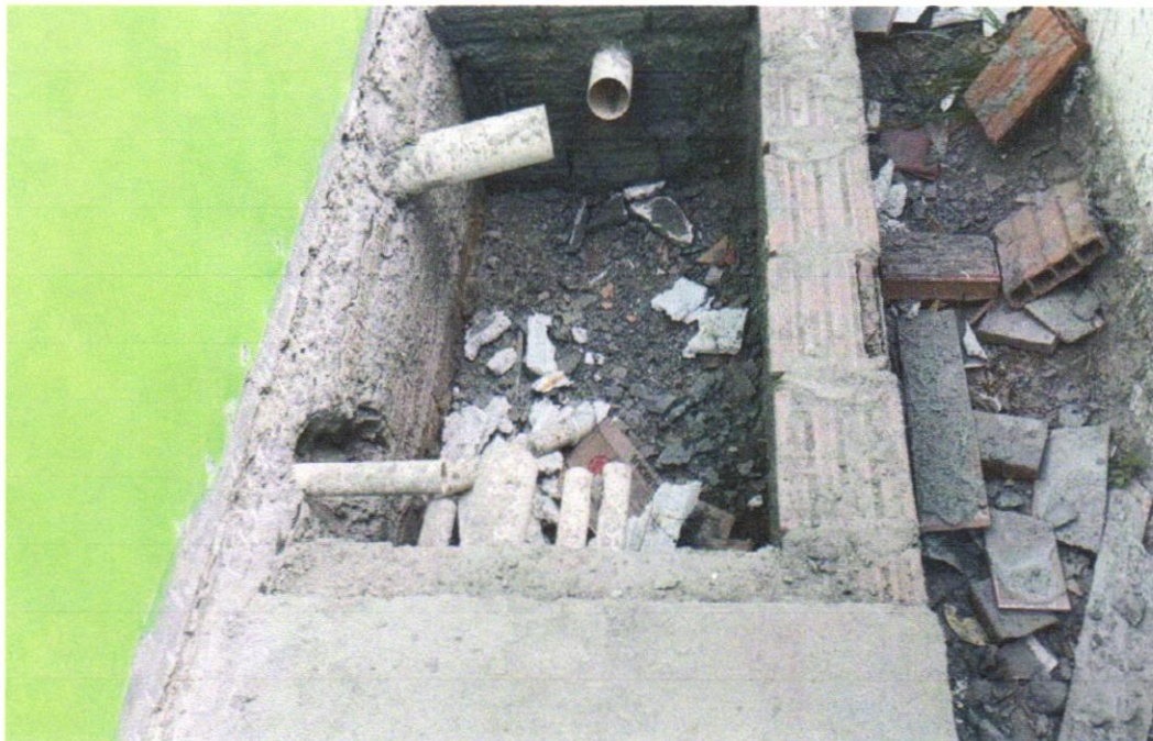
Foto 14 - Sumidouro paredes com blocos cerâmicos 6 furos e dimensões internas de 1,75 x 1,00 x 1,00 m
