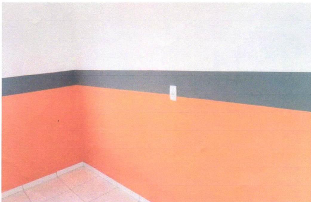
Foto 18 - APLICAÇÃO MANUAL DE PINTURA COM TINTA LÁTEX ACRÍLICA EM PAREDES, DUAS DEMÃOS. AF_06/2014
